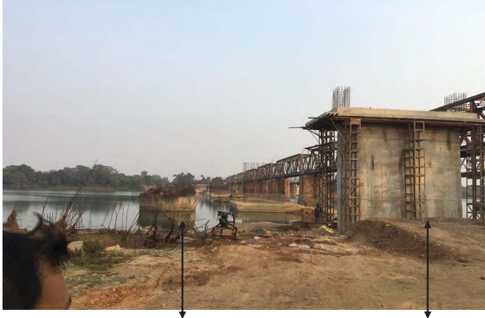
चित्र 3.10: अच्छी नींव के साथ निर्मित छोडा गया पुल भरी गई नींव के साथ निर्मित नया पुल
